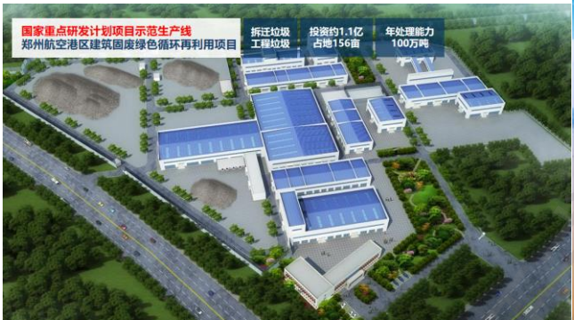
图8 郑州航空港区固废绿色循环利用项目示范生产线
