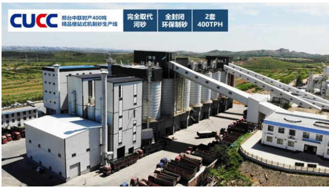
图6 邢台中联 400t/h 精品制砂楼系统生产线
